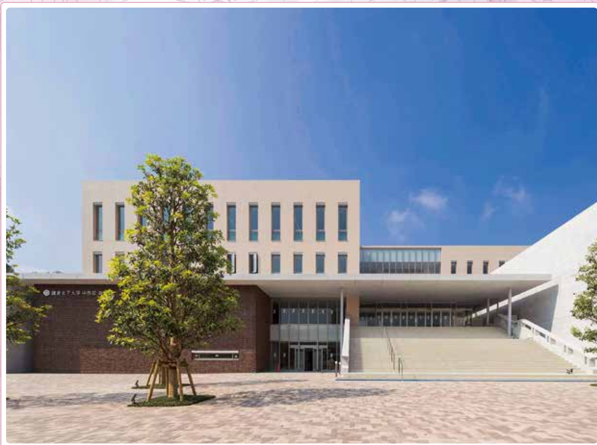
岩瀬キャンパス中部・高等部 新校舎正面エントランス
